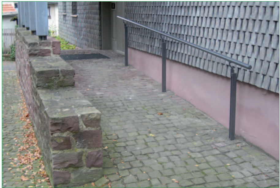
Handlauf am rückwärtigen Eingang des Rathauses
