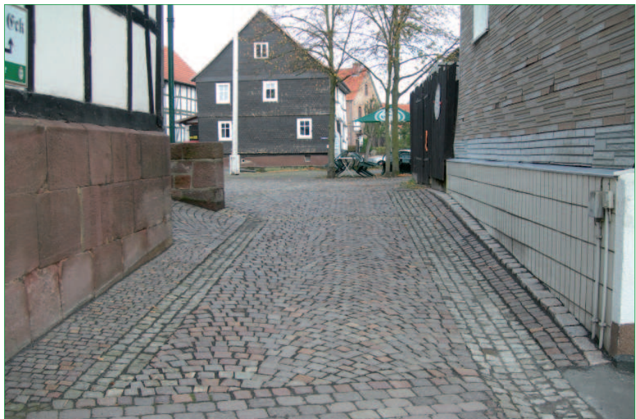
Entschärfung eines steilen Teilbereichs der Sandkaute
